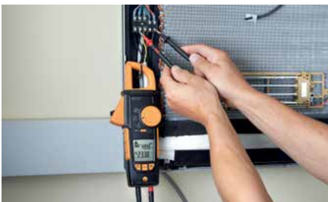
Измерение напряжения на блоке кондиционера с testo 770 .
