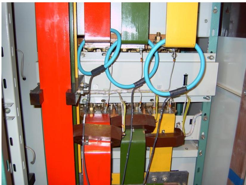
**Рис. 2.4.** Установка клещей 300 / 3000 А на шины
