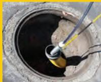
Вспомогательные устройства для ввода (вставная втулка и гибкая защитная труба)
