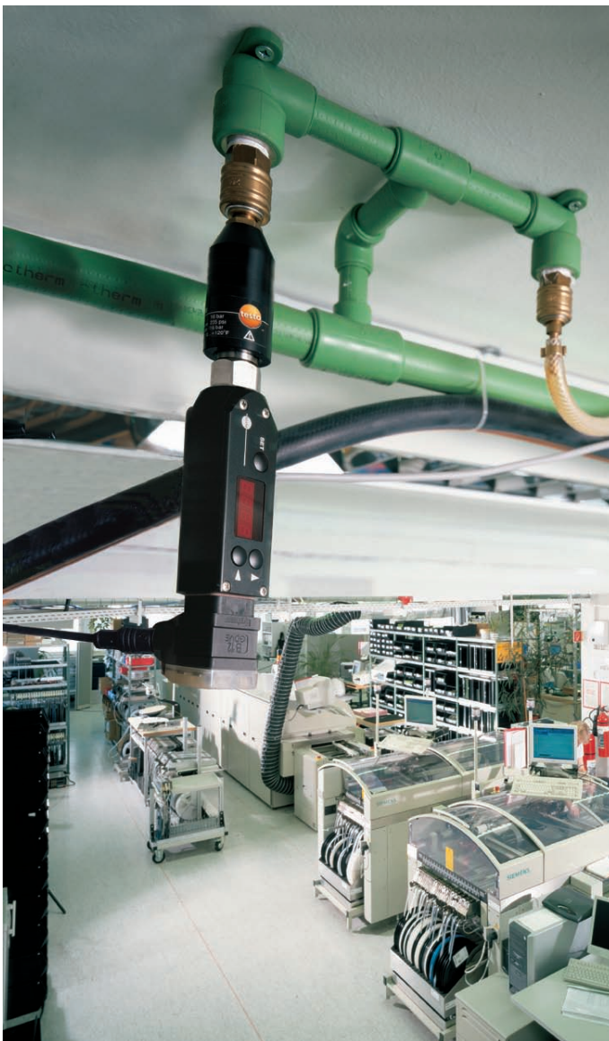
Прибор testo 6740 выполняет мониторинг влажности в сжатом воздухе непосредственно перед подачей потребителю – например, при производстве электронного оборудования.
